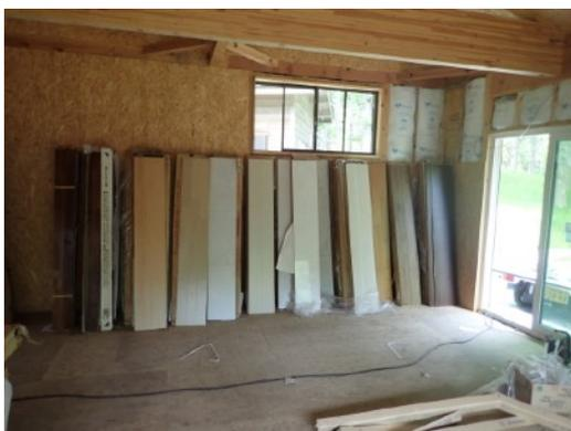
倉庫横の材木置き場から間柱を運搬して作業を開始しました。柵の取り付け作業が終了して、次はフローリングを貼ります。知り合いの材木屋さんから約25坪分のフローリング材（12種類）をいただいていたのですが、色合い・柄はばらばらでそれを全部並べてみてからどこにどの材料を施工するか？検討しました。ロフトには天然材のチーク材（高級品）を施工します。天然材は湿度や温度で変形することがありますそこで、床材にボンドを塗りながら作業しなければならないので手間がかかります。2日目
